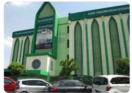
Gedung F. Keperawatan
